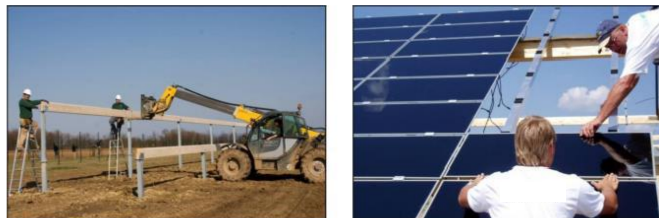
Illustration 27 : Montage des structures porteuses et des modules
