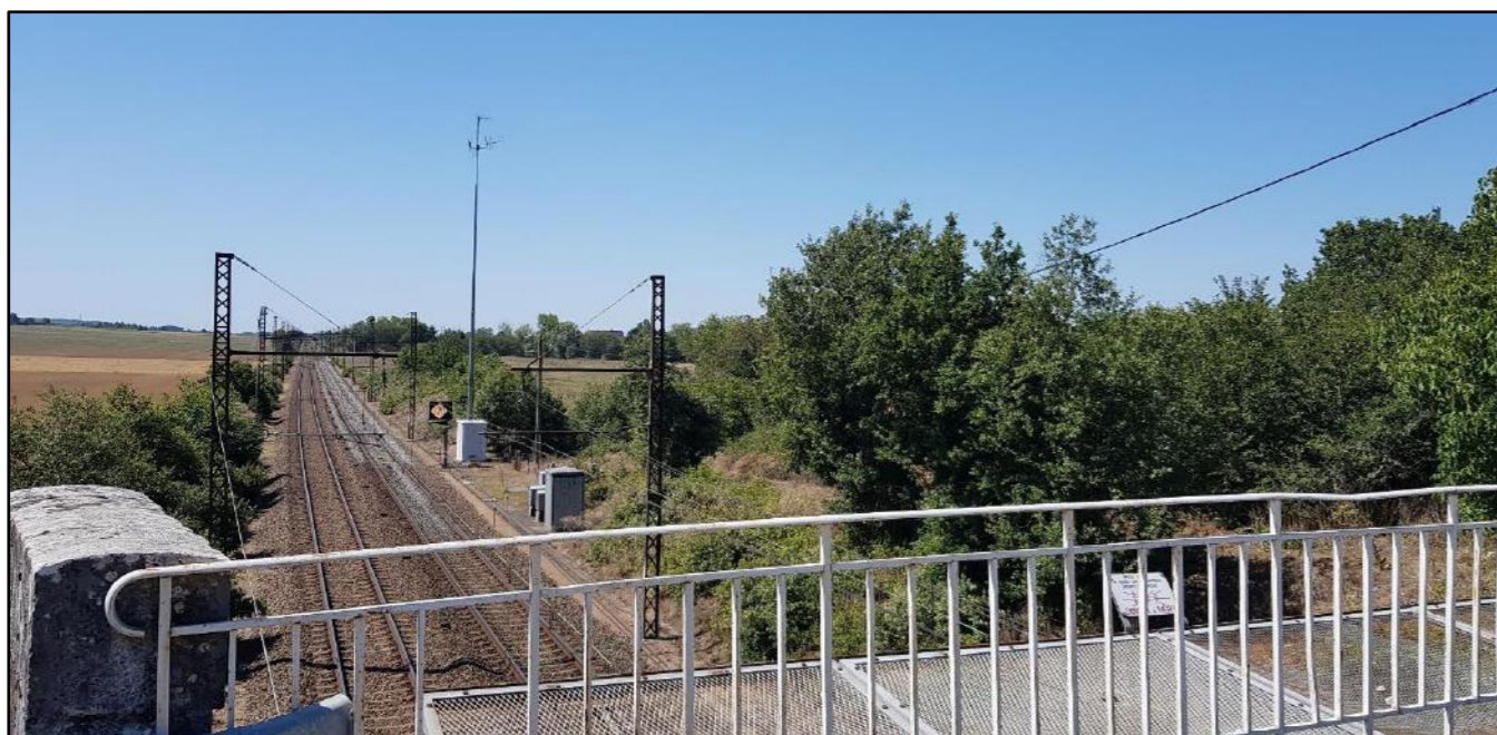
Illustration 136 : Voie SNCF à l'est du projet (Source : EREA Ingénierie – Août 2018)
