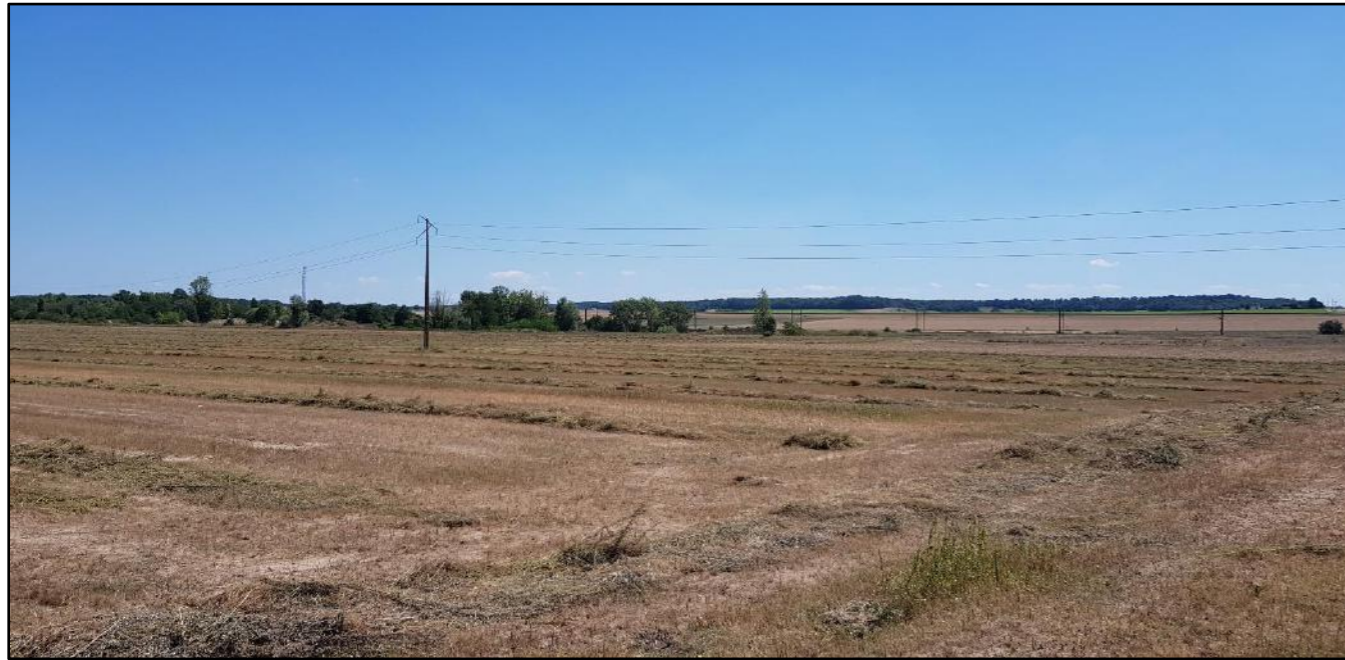
Illustration 27 : Vue sur la ligne électrique aérienne HTA, et site du projet en arrière-plan (Source : EREA Ingénierie – août 2018)
