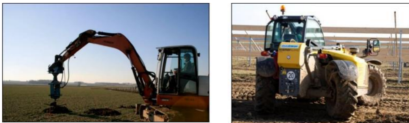
Illustration 26 : Exemple d'engins nécessaires sur le chantier
