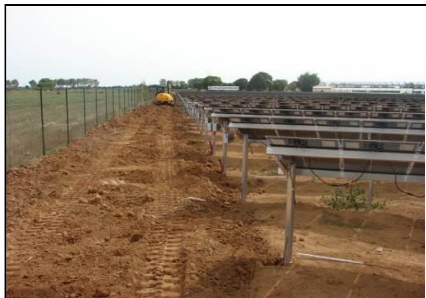
Illustration 181 : Récouvrement des tranchées
